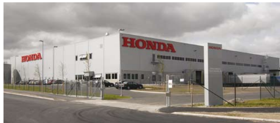
Nybyggnad av lager med miljöprofil för Honda i Burlövs kommun utanför Malmö. 7 700 kvm lager och 1 900 kvm entresol med 450 kvm kontor. Byggnaden uppfyller Hondas globala miljömål.
